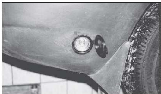
Rys.12. Zamontowany wlew gazu
